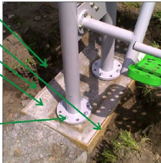
Rys. 48 Posadowienie pylonu urządzenia fitness w podłożu.
